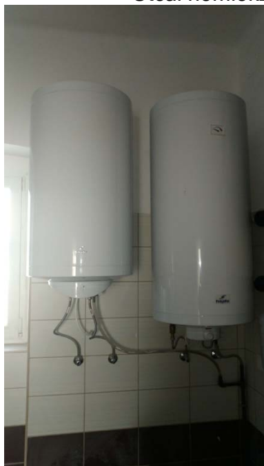
Melegvíz előállítás mennyezeti világítás
