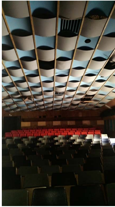
Moziterem mennyezeti befúvás Melegvíz előállítás
